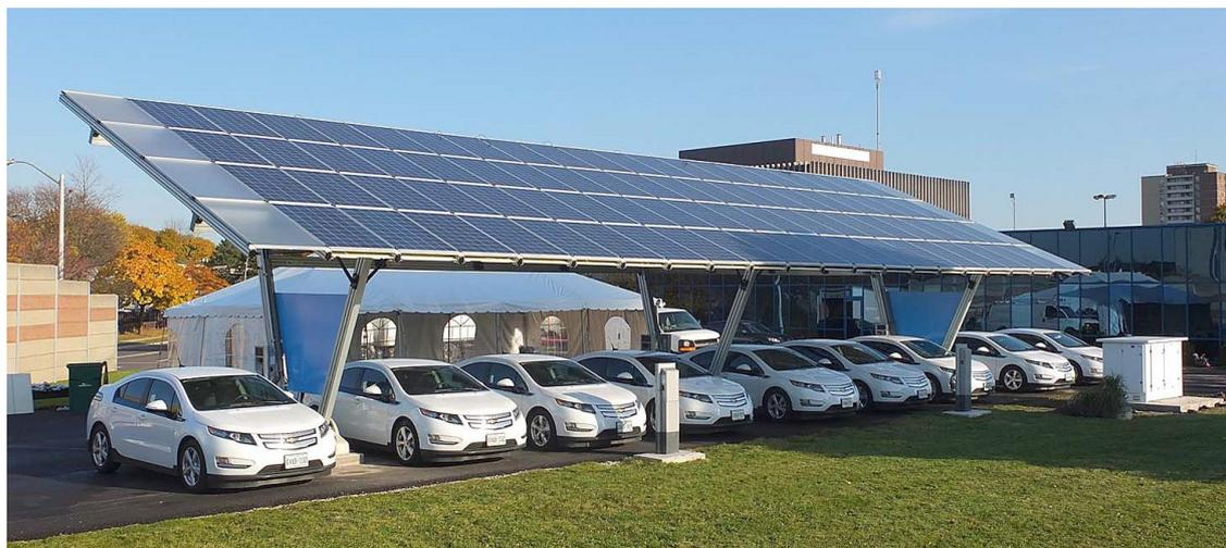
Carros elétricos em uma estação de abastecimento com painéis solares fotovoltaicos.
